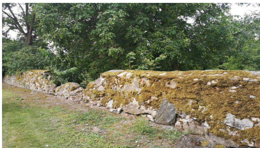
10. Fragment kamiennego muru (od strony zachodniej parceli)
