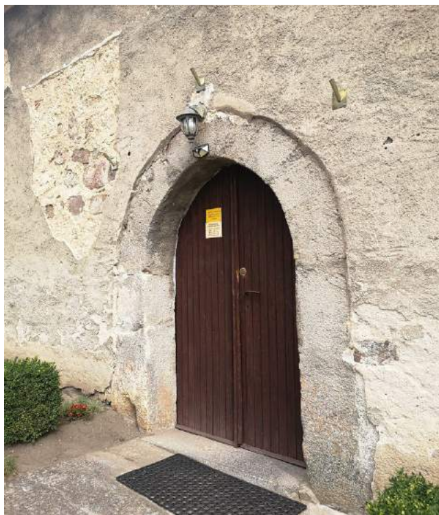
9. Portal w elewacji południowej
