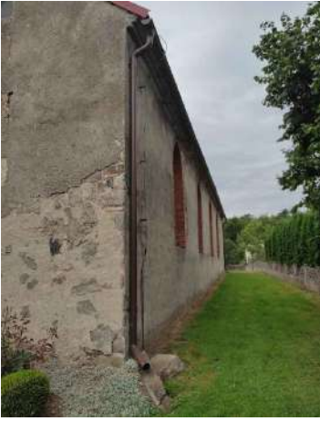
Fot. 1 Elewacja ściany północnej kościoła (narożnik półn. - wsch.)
