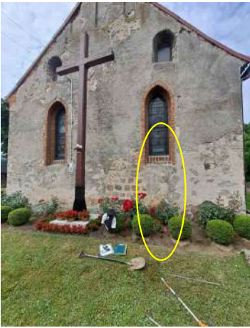
Fot. 1 Lokalizacja odkrywki "A"
