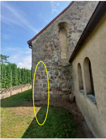
Fot. 1 Lokalizacja odkrywki "B"
